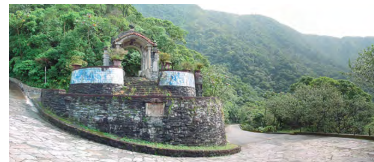
Padrão do Lorena, onde a Estrada Velha se encontra com o Calçada do Lorena
