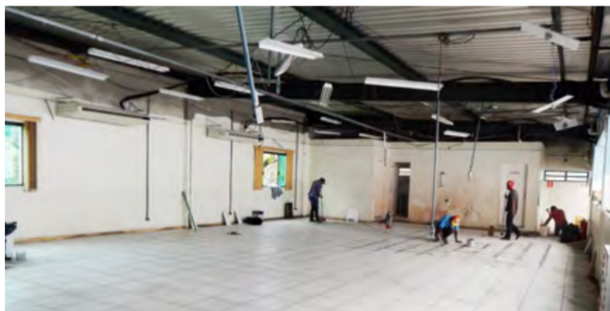
Salas de Atividades em reforma
